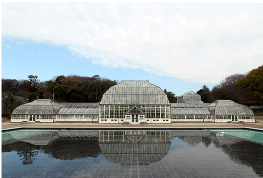
復原工事が完了した重要文化財温室。
