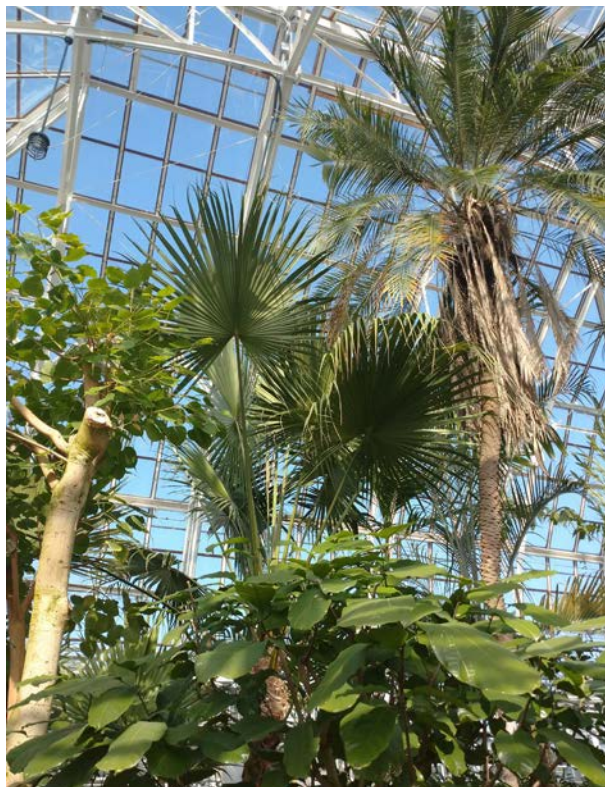
植栽工事が完了した中央ヤシ室。
