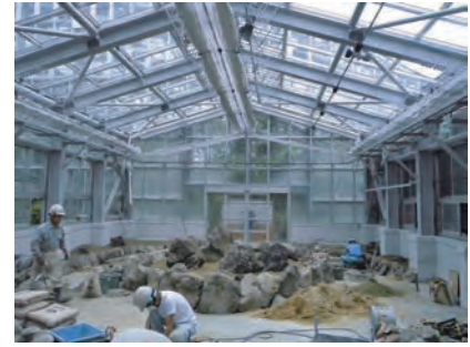
図20 石工事（高山植物室）
