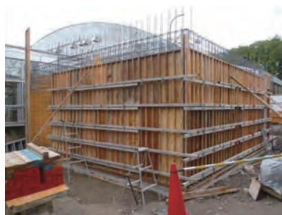
図12 型枠工事（昼夜逆転室）
