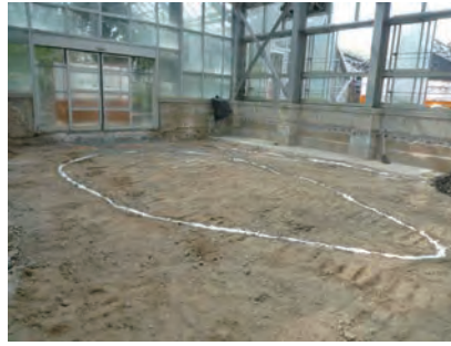
図19 土・地業工事（高山植物室）
