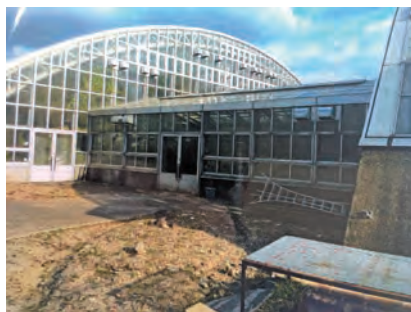
図9 増設前の状態（昼夜逆転室）
