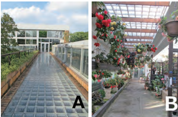
図4 プリズムガラス造りの採光床 A: 2階から。B: 1階(鉢花室)から。
