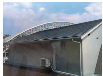
図13 外装完成（昼夜逆転室）
