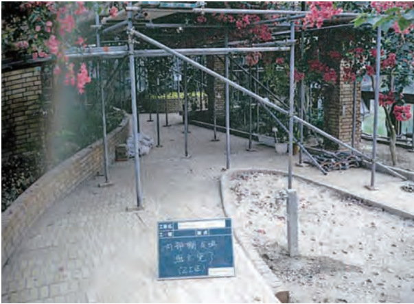
図26 足場の様子(廻廊温室)
