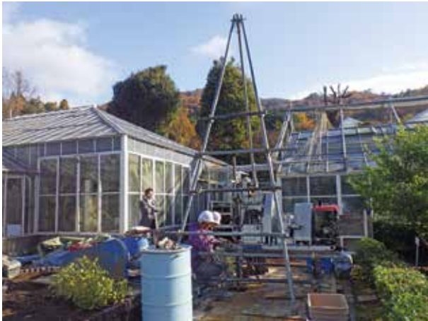
図7 ボーリング調査の様子.
