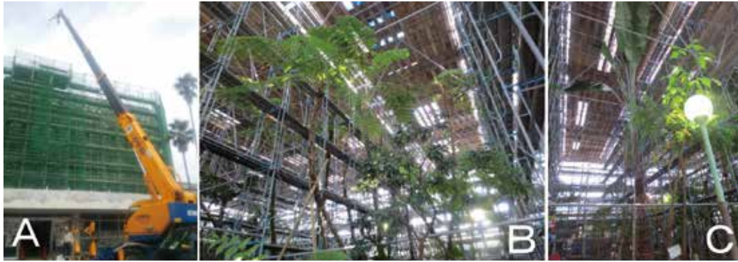
図10 建物の改修工事と植物の管理。A：温室周辺に組まれた工事用足場。B：足場が組まれた温室内部と植物の様子。C：くまなく組み上げられた足場に囲まれ暗いので、植物のために照明をつける。
