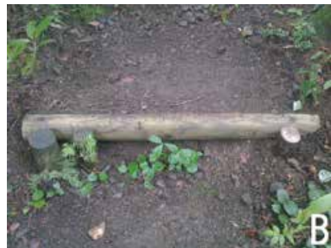
図3 観察路施設の補修例。A：交換前。B：交換後。モミ・コナラ・イワガラミ（稚樹）が、蹴込み付近の表面侵食を抑えていると考え（蹴込み付近の路面が洗掘を受けやすい）、これらをできるかぎり保護して腐朽部材のみを交換した。
