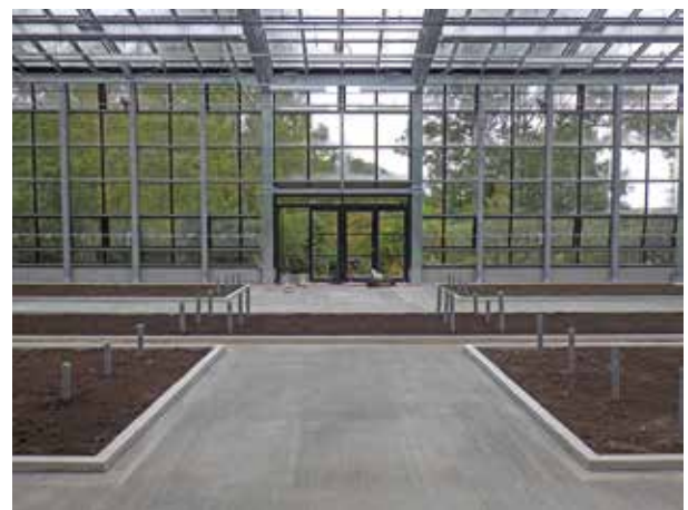
図10 広くなった通路.
