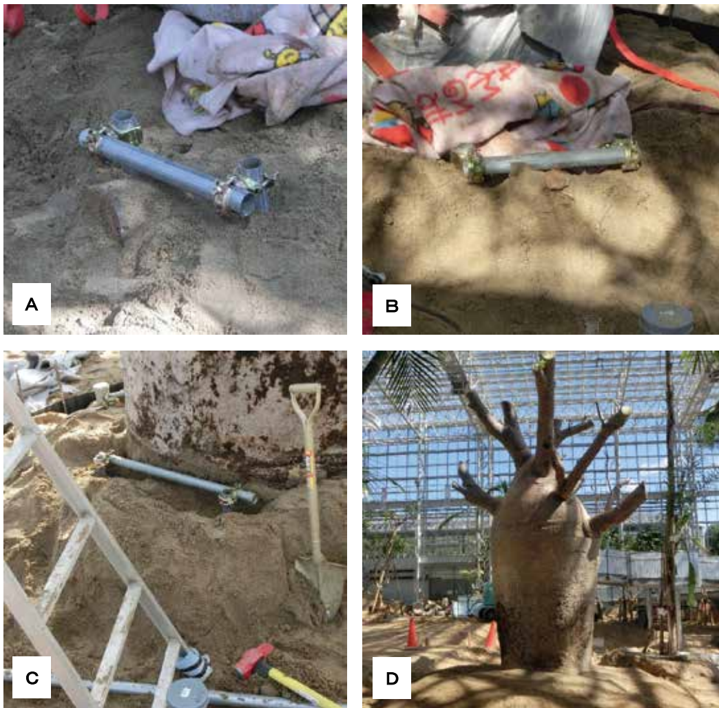
図14 地下支柱設置・盛り土. A: 幹を押さえる支柱（北側）。B: 幹を押さえる支柱（西側）。C: 幹を押さえる支柱（東側）。D: 盛り土をした様子。
