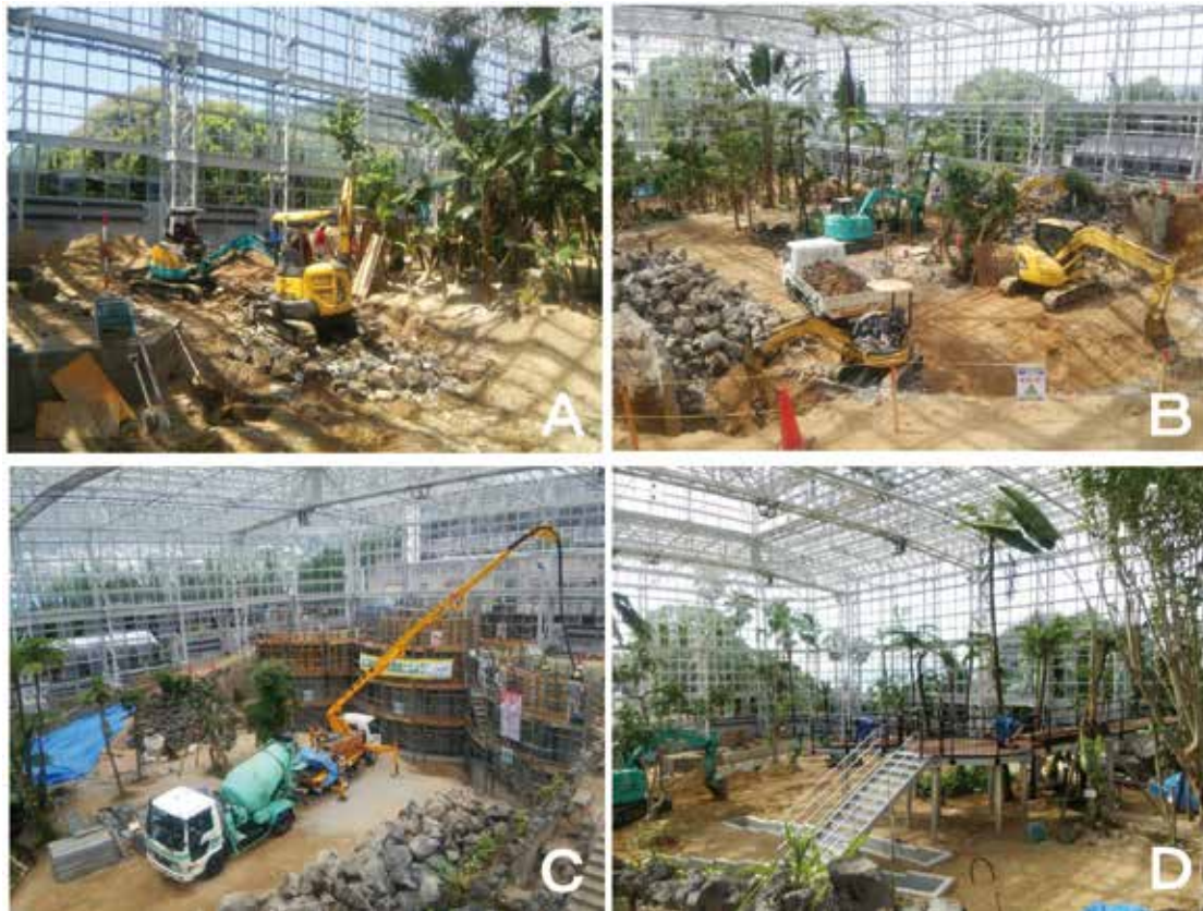
図13 展示施設基盤等整備工事。A：既存の池や通路等の取り壊し。B：既存の熔岩壁やトンネルの取り壊しと熔岩の再利用のための積置き。C：熱帯古城の熔岩壁造成工事。D：スロープデッキ通路の組み立て工事。
