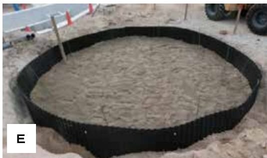
図11 定植場所の土壌改良。A：完成イメージ図。B：バックホウにより掘った穴。C：底にボラ土を敷きつめた。D：在来の真砂土を投入。E：加工砂を投入。F：8本の塩ビ管を設置。
