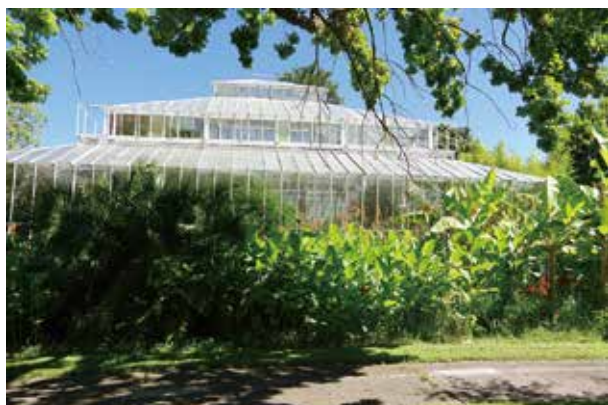
図26 閉館中の温室。
