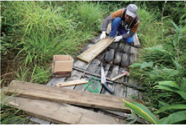
図11 傷んだ歩道を修理する。
