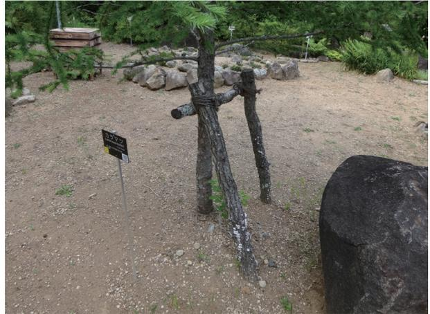
図12 丸太材による二脚鳥居支柱。
