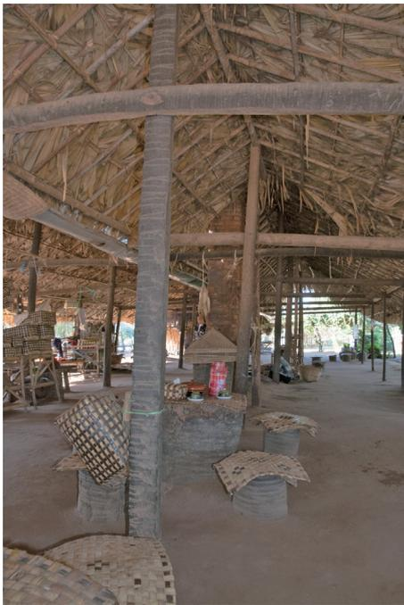
図8 オウギヤシ加工場の中の様子。柱と机、椅子はオウギヤシの幹で作られ、籠、テーブルクロス、座布団はオウギヤシの葉で編まれている。
