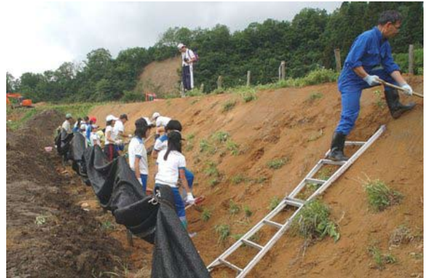
図3 地域の自然関連団体、小学校による復旧作業
